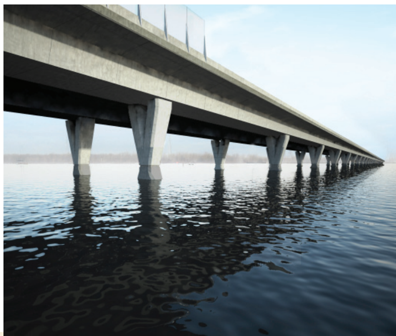
PONT AU-DESSUS DU FLEUVE SAINT-LAURENT
