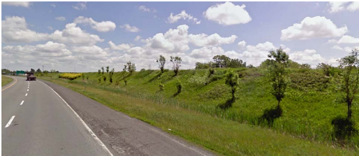
Autoroute 30 sur la rive-sud
