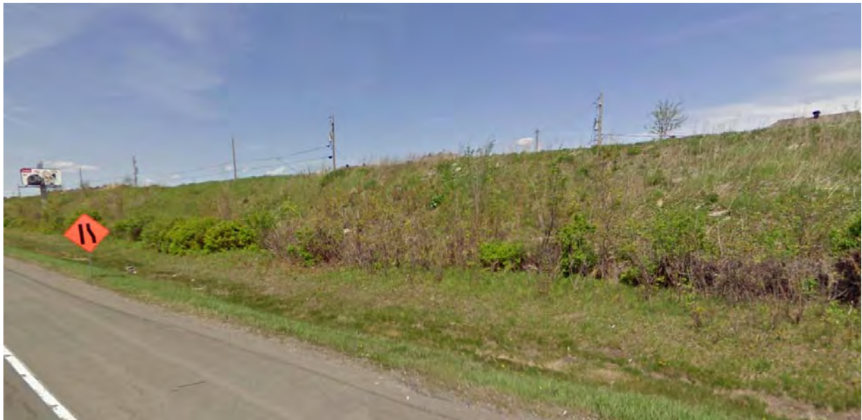
Autoroute 15 à Laval
